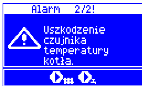
Rys. 30 Widok alarmu „uszkodzenie czujnika temperatury kotła”.
